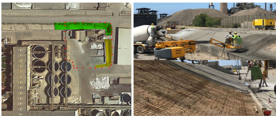
Figura 8. Area interessata dagli interventi con Spritz Beton
